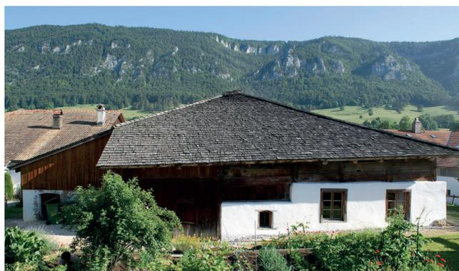
Figure 11 Façade sud. La toiture (à quatre pans) a bénéficié d'une nouvelle toiture recouverte de bardeaux. (Photographie extraite du film)
